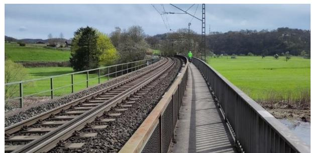
*Foto 20: Der Fußweg über die Bahnbrücke von Stein-Auel ist für die Nutzung durch den Radverkehr deutlich zu schmal.*
