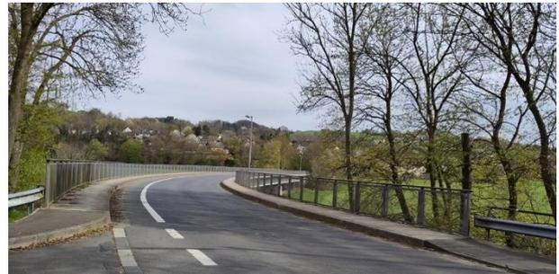
*Foto 18: Bei Führung der Pendlerroute über die Brücke der K36 sollte die Aufteilung der Verkehrsräume angepasst werden – der derzeit vorhandene Mehrzweckstreifen ist nur in einer Richtung nutzbar.*
