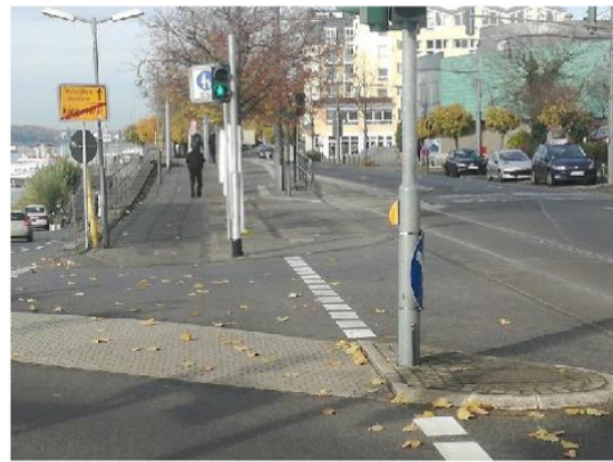
Foto 32: Vor der Fährzufahrt wird der Radverkehr in Südrichtung auf den Bordstein zurückgeführt. Der Radverkehr in Nordrichtung wird links neben dem Bahnsteig auf die Kragfläche geführt.
