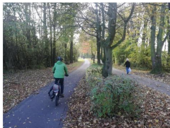
Foto 20: Der Weg durch die Rheinaue ist mit 1,5 m Breite viel zu schmal; die Oberfläche sollte saniert und verbreitert werden.
