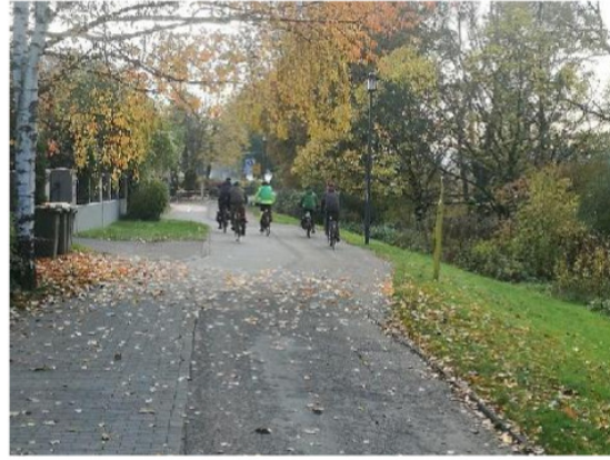
Foto 22: Unmittelbar bevor die Stadtbahntrasse erreicht wird, führen Radweg und Fußweg zusammen; bei irreführendem Pflaster. Die Wegfläche ist zu verbreitern; Rad- und Fußweg zu trennen.
