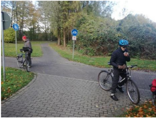
Foto 21: Das Pflaster im Bereich der Johannes-Albers-Allee sollte durch Asphalt ersetzt werden.
