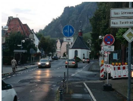
Foto 56: Die vorhandenen Schutzstreifen verleiten zum Überholen trotz zu geringer Platzverhältnisse. Sie sind zu entfernen, ein Überholverbot von Radfahrenden sollte angeordnet werden. Das Linksabbiegen jeweils hinter der Kapelle ist zu erleichtern.
