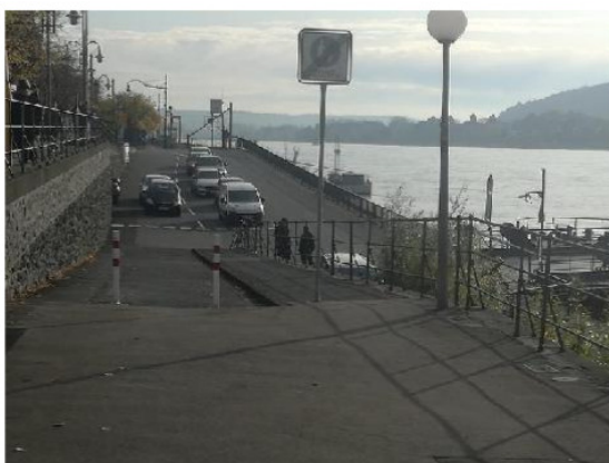
Foto 33: Der Radweg in Nordrichtung führt parallel zum Bahnsteig oberhalb der Fährzufahrt über eine von Auskragungen getragene Fläche.
