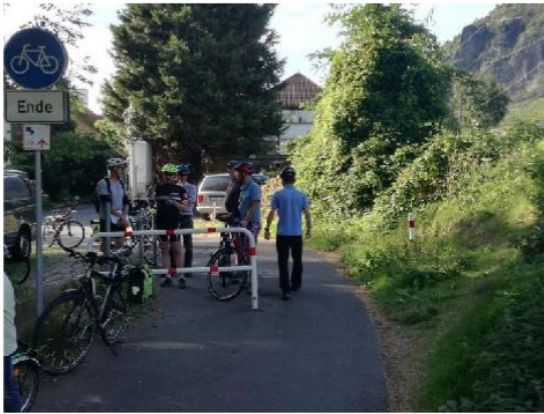
Foto 45: Am Ende der Karl-Broel-Straße sollten die Umlaufsperrung entfernt und ggf. Bodenschwellen aufgebracht werden.
