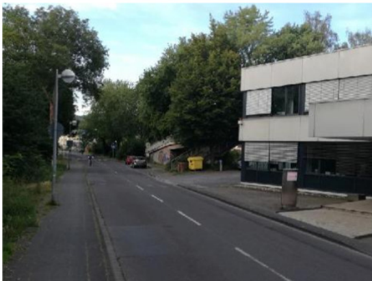
Fotos 53+54: Der Fußweg der Lohfelder Straße ist mit knapp 2 m Breite zu schmal, um den Radverkehr aufzunehmen. Eine sichere Befahrbarkeit dieses ca. 1 km langen Abschnittes kann nur gewährleistet werden, indem eine Fahrspur in eine Protected Bike Lane umgewandelt wird. Dazu muss der Kfz-Verkehr in einer Fahrtrichtung über die B42 geführt werden.
