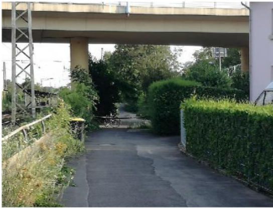
Foto 51: An der Steinstraße ist die Schranke zu entfernen und der Belag zu sanieren.
