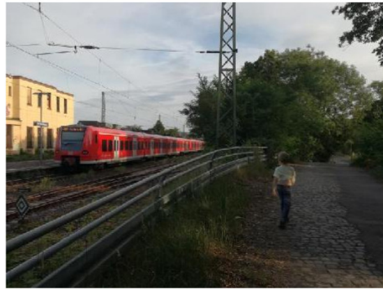
Foto 52: Am Bahnhof Bad Honnef sollten ein einseitiger Zugang gebaut sowie Fahrradabstellmöglichkeiten geschaffen werden.
