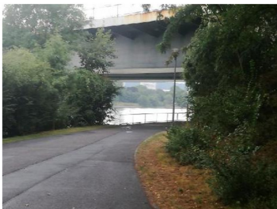
Foto 01: Südbrücke/Trajektumfahrung: eine Trennung vom Fußgängerverkehr ist wünschenswert.
