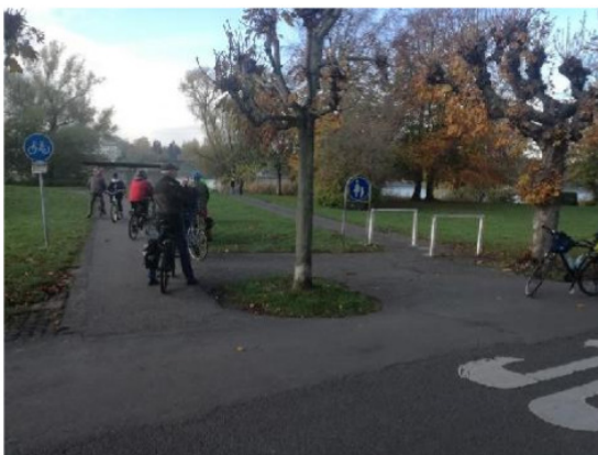
Foto 19: Auch bei der zweiten Kurve (im Hintergrund) sollte im Zuge der Verbreiterung und Sanierung des Radwegs der Radius vergrößert werden.
