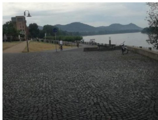
Foto 02: Bonner Bogen - im Bereich der Pflasterung werden die vorher und hinterher getrennten Wege vermischt, die Oberfläche ist ungeeignet.
