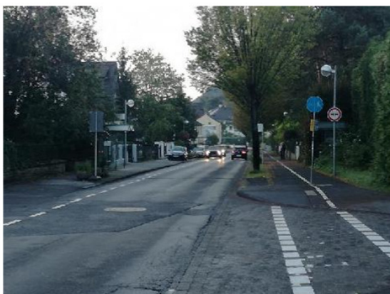
Foto 57: Die Rhöndorfer Str. und im weiteren Verlauf die Hauptstraße in Bad Honnef eignen sich aufgrund der beengten Platzverhältnisse nicht für die Radroute. Die heutigen Radwege (soweit vorhanden) sind nicht ERA-konform.
