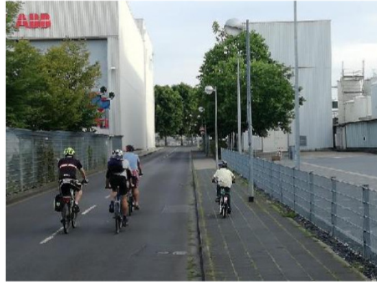
Fotos 53+54: Der Fußweg der Lohfelder Straße ist mit knapp 2 m Breite zu schmal, um den Radverkehr aufzunehmen. Eine sichere Befahrbarkeit dieses ca. 1 km langen Abschnittes kann nur gewährleistet werden, indem eine Fahrspur in eine Protected Bike Lane umgewandelt wird. Dazu muss der Kfz-Verkehr in einer Fahrtrichtung über die B42 geführt werden.
