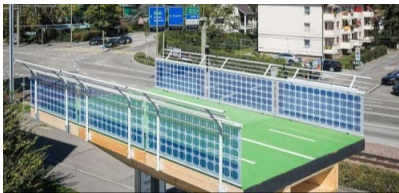
Modell eines aufgeständerten Wegemoduls für Radschnellwege. © Schweizer Start-up-Unternehmen https://www.urb-x.ch/
